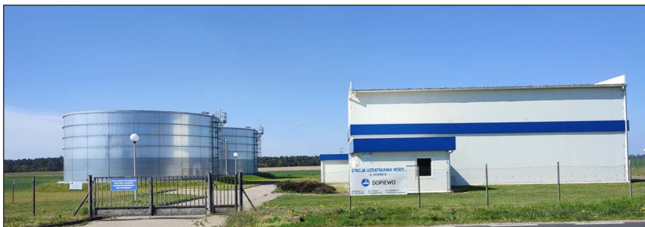
Stacja Uzdatniania Wody w Joance
