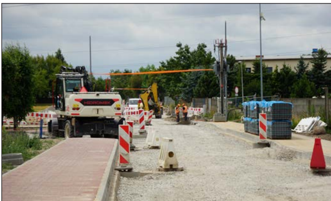
Prace na ul. Leśnej w ramach etapu II, sierpień 2023 r.
