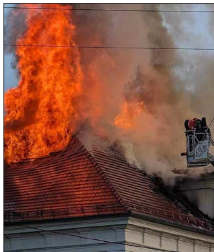
Pożar poddasza i dachu, 11 lipca 2023 r.
