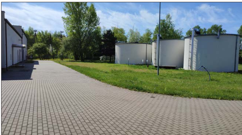
Stacja Uzdatniania Wody w Skórzewie
