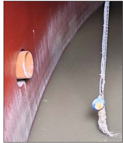
Skrątki zwisające z pływaka pompy
