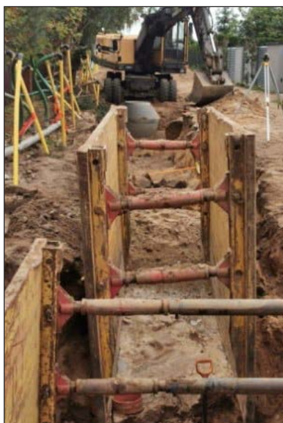
Budowa kanalizacji sanitarnej w Zakrzewie
