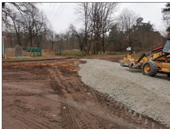
Odtwarzanie nawierzchni dróg po budowie kanalizacji sanitarnej w Zakrzewie
