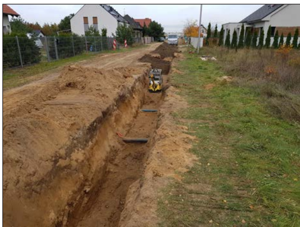
Budowa kanalizacji sanitarnej w Dąbrowie
