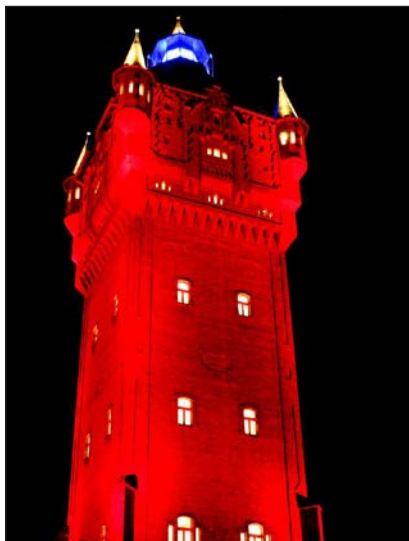
Wieża ciśniń w Śremie, fot. archiwum urzędu miejskiego w Śremie
