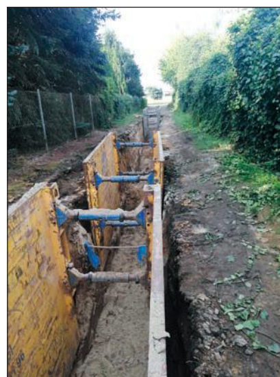
Budowa sieci kanalizacji sanitarnej w m. Skórzewo ul. Żeglarska - Maratońska - fot. Jacek Kokociński
