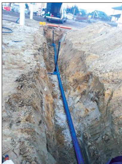
Budowa sieci wodociągowej w m. Zakrzewo ul. Orkiszowa - fot. Jacek Kokociński
