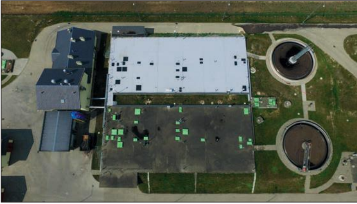
Oczyszczalnia ścieków w Dąbrówce - fot. Archiwum
