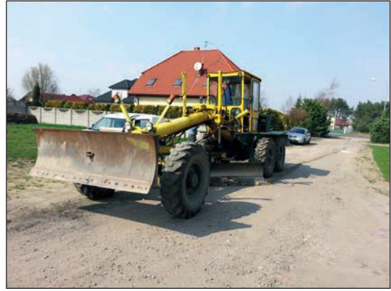
Profilowanie nawierzchni dróg gruntowych - fot. Jakub Jezierski
