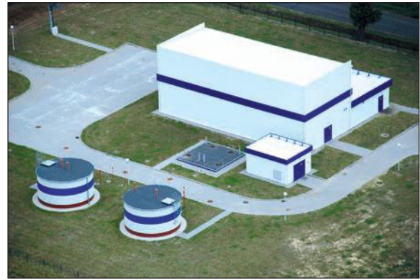
Stacja uzdatniania wody w Joance - fot. Archiwum
