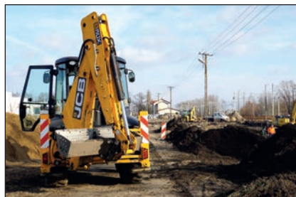
Pałędzie - początek budowy węzła
