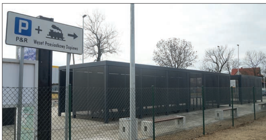
Wiata rowerowa węzła przesiadkowego w Dopiewie
