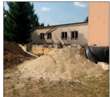
Rozbudowa pałędzkiego Domu Strażaka ma zakończyć się we wrześniu
