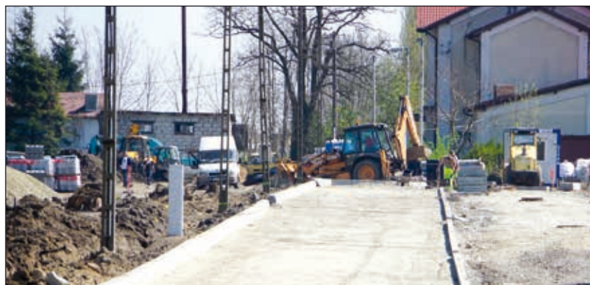
Budowa Zintegrowanego Węzła Przesiadkowego przy stacji Pałędzie
