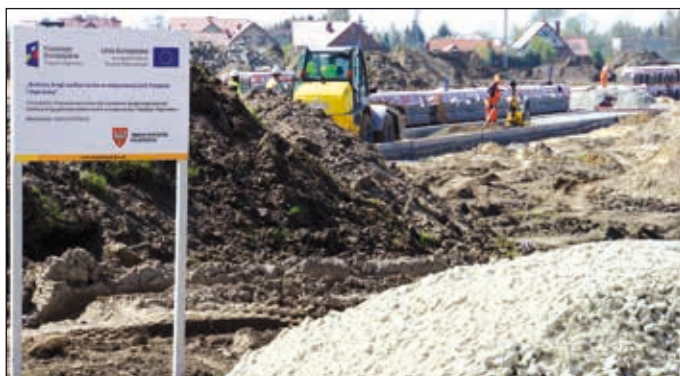
Budowa Drogi Wzdłuż Torów
