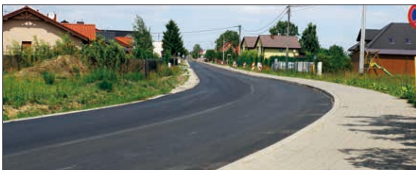
Ul. Szkolna w Konarzewie - po remoncie, lipiec 2018
