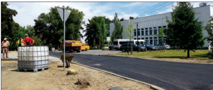
Remont drogi i miejsc parkingowych - okolice CRK
