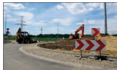
Prace wykończeniowe na rondzie, lipiec 2018 r
