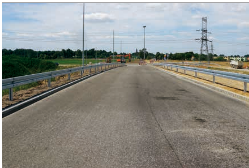
Konarzewo - powstaje węzeł
