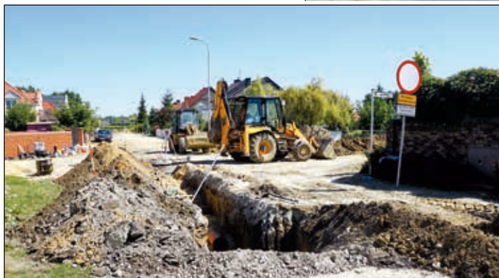
Budowa drogi - ul. Żłota i Radosna w Skórzewie
