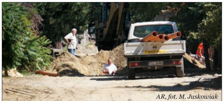
AR, fot. M. Juskowiak Budowa kanalizacji w Zakrzewie - ul. Łąkowa
