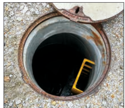
Budowa kanalizacji w Zakrzewie - ul. Łąkowa
