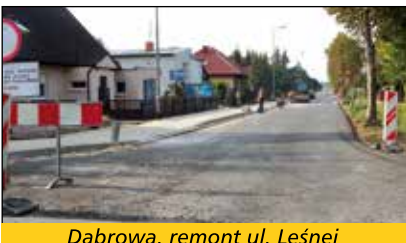
Dąbrowa, remont ul. Leśnej
