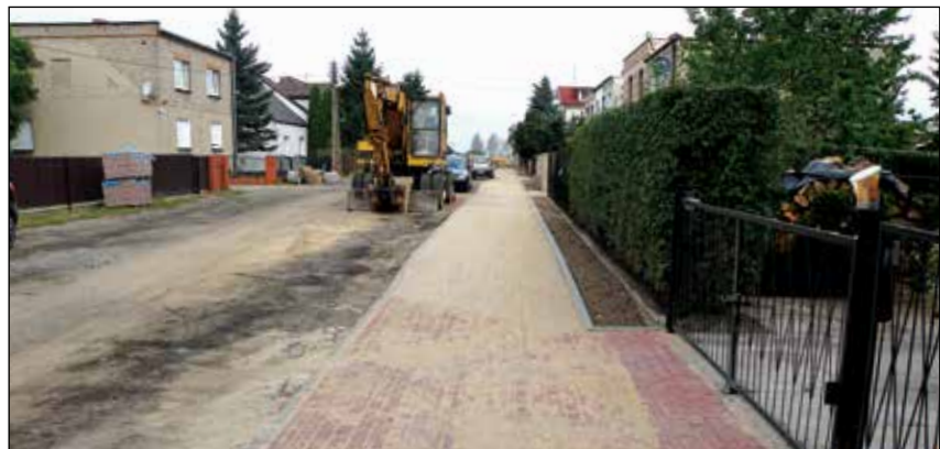
Dopiewo - budowa ul. Północnej
