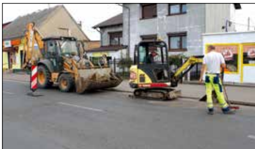
Dopiewo, ul. Wyzwolenia - modernizacja drogi
