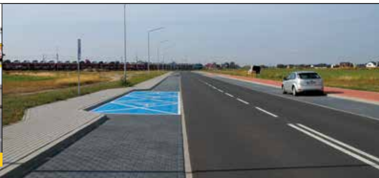
Dąbrówka - Pałędzie, droga wzdłuż torów
