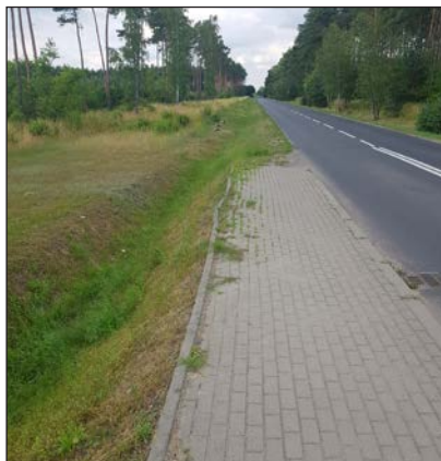
Budowa chodnika - Zakrzewo
