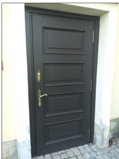
Konarzewo-nowe drzwi do kruchty bocznej
