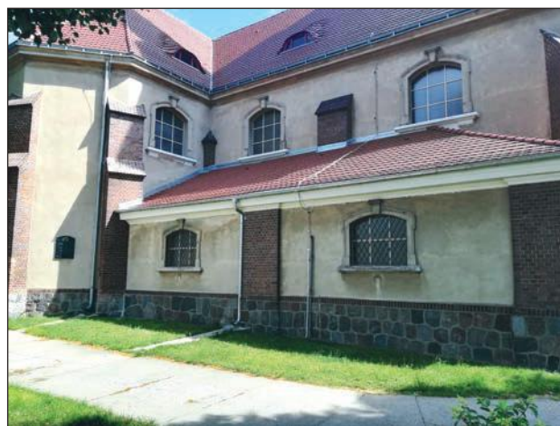
Skórzewo- wyremontowany dach na bocznych przybudówkach
