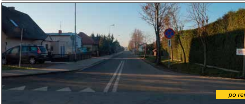
Dąbrowa - ul. Leśna, przed remontem
