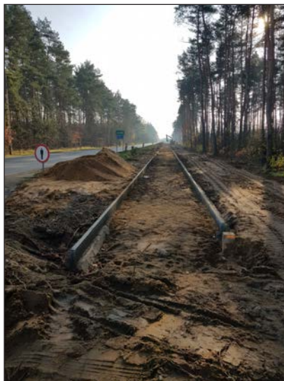
Budowa chodnika w Zakrzewie
