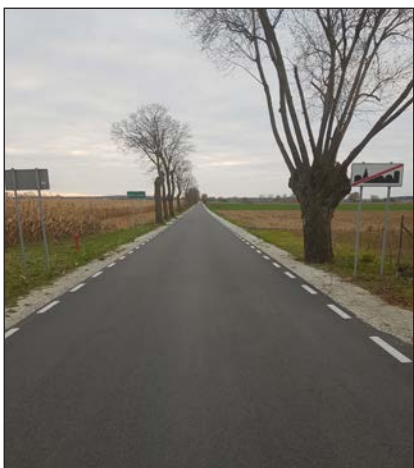
Wyremontowana droga powiatowa: Konarzewo – Trzcielina
