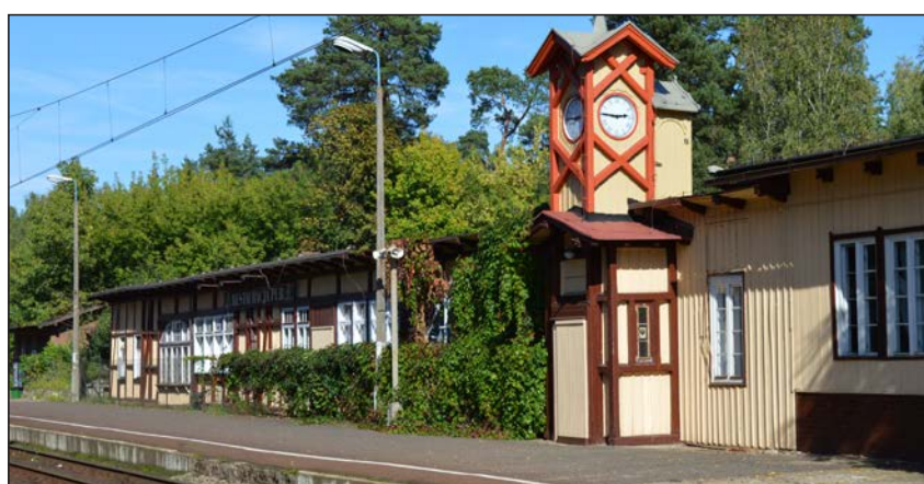
Budynek dawnego dworca w Puszczykowie (fot. Anna Polaszczyk)
