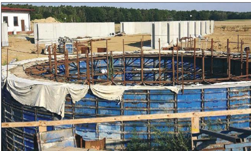
Rozbudowa oczyszczalni w Dopiewie
