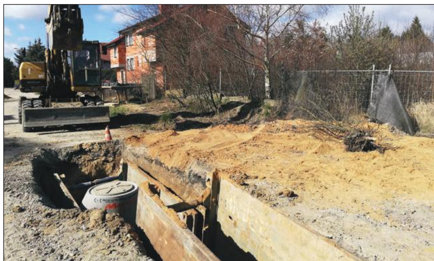
Budowa kanalizacji – ul. Piłkarska w Skórzewie
