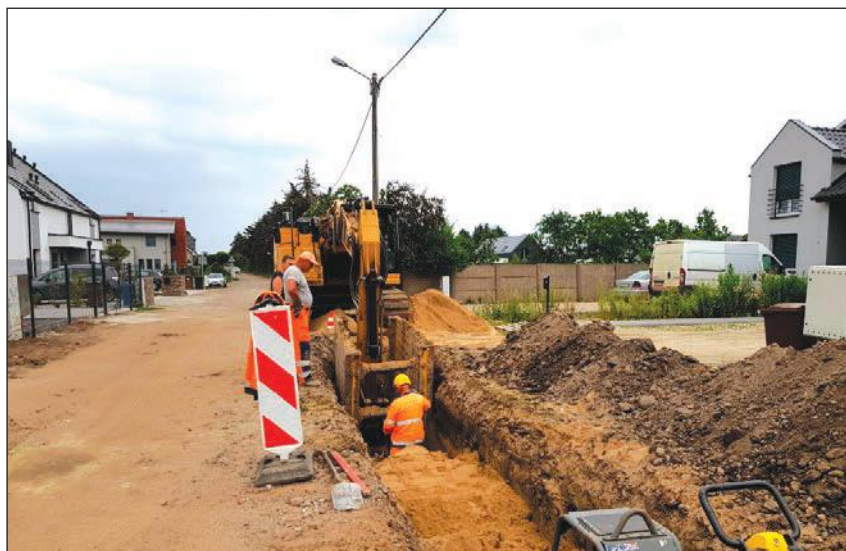
Budowa kanalizacji – ul. Leśna w Dąbrowie
