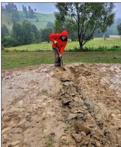
Początek budowy domu w Bieszczadach
