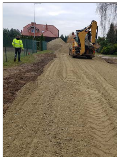
Odtwarzanie nawierzchni dróg po budowie kanalizacji sanitarnej
