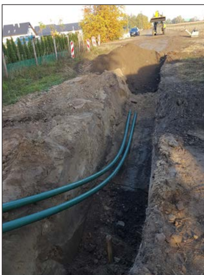
Budowa kanalizacji sanitarnej w Dąbrówce
