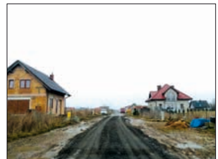
Prace interwencyjne na ul. Lipowej w Dopiewie, zlecone przez Urząd Gminy Dopiewo Zakładowi Usług Komunalnych Sp. z o. o
