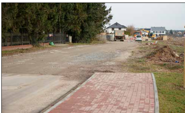
Rozpoczęta budowa drogi na ul. Leśnej - od ul. Rolnej do ul. Dojazd.
