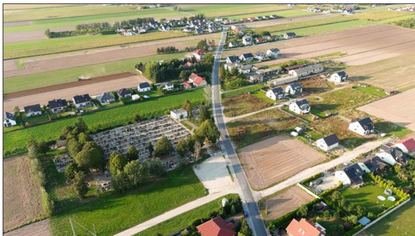
Ukończona ul. Ks. A. Majcherka w Dopiewie
