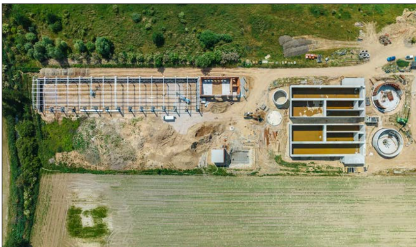
Rozbudowa oczyszczalni ścieków w Dąbrówce
