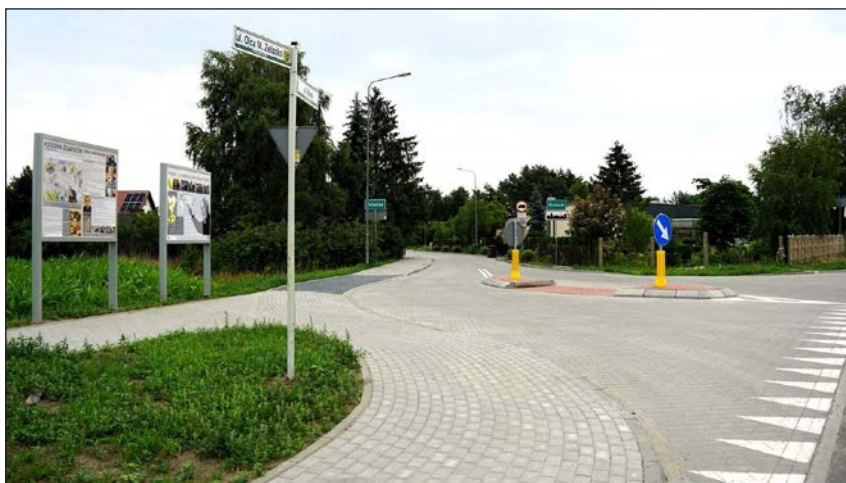
Ul. Nowa w Palędziu po przebudowie
