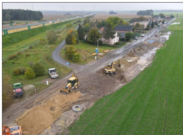
Budowa kanalizacji sanitarnej Dopiewo ul. Wiśniowa
